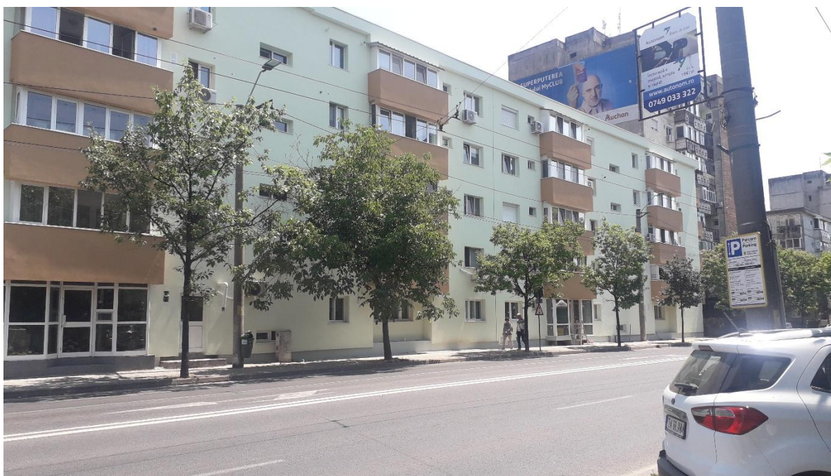
27. Reabilitare termică imobil Calea Torontalului nr. 14
