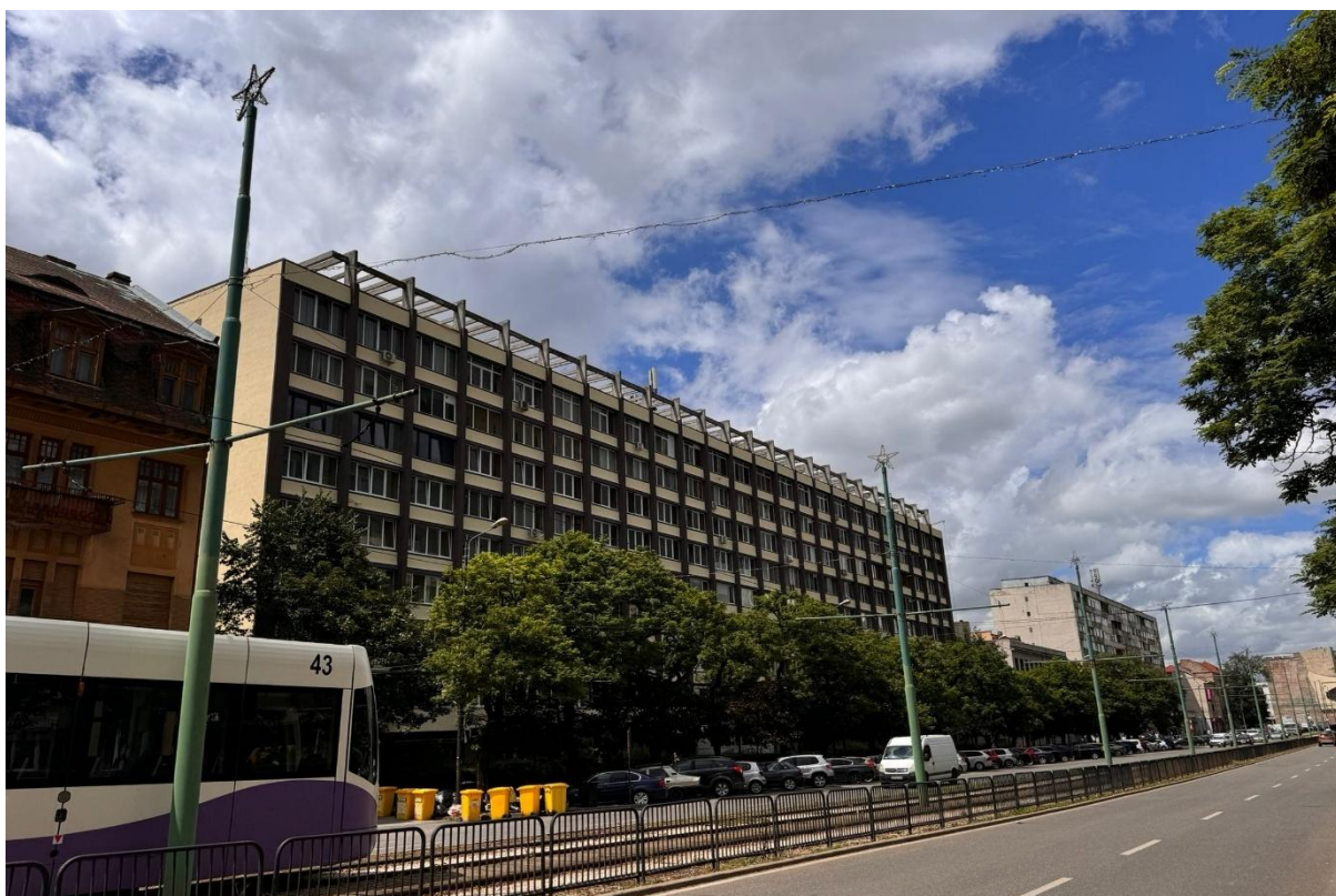
22. Reabilitare termică imobil str. Teiului nr. 11
